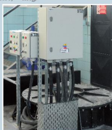
A régi gázolaj-üzemeltetési szivattyúkat villanyturbinák váltották fel
