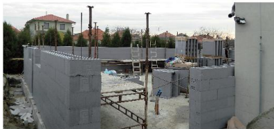
Hamarosan befejeződik a földszint falazása
